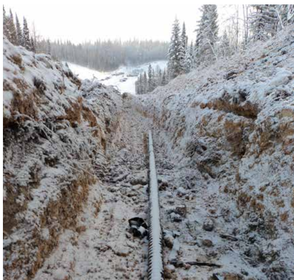
Sheltons fältpipeline från brunn till faciliteter
